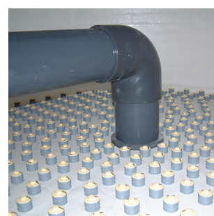
Falešné dno se vzduchovými tryskami
