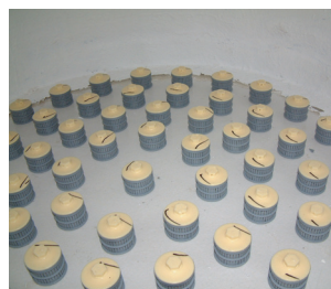
Detail falešného dna se vzduchovými tryskami
