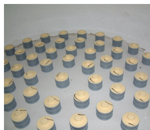
Detail falešného dna se vzduchovými tryskami
