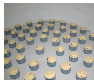
Detail falešného dna se vzduchovými tryskami
