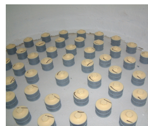
Detail falešného dna se vzduchovými tryskami
