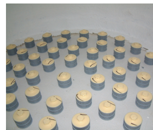
Detail falešného dna se vzduchovými tryskami
