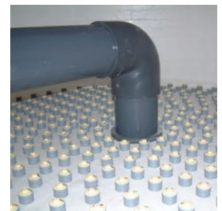
Falešné dno se vzduchovými tryskami
