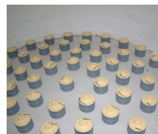
Detail falešného dna se vzduchovými tryskami
